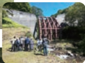
鋼製フレームの透過型ダム「黒川沢里見第2号砂防堰堤」。
